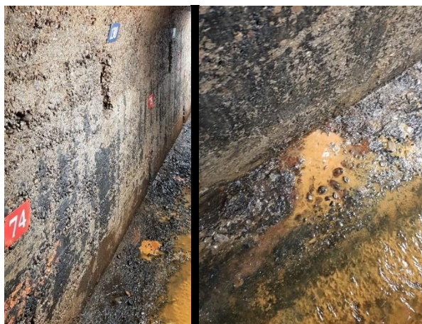
Figure 26 - Amas de boues orange hors écoulement des barbacanes
