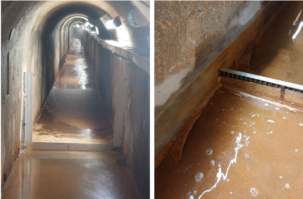
Figure 45 – A gauche : Plaque amovible actuellement en place entre les deux conduite 500mm
