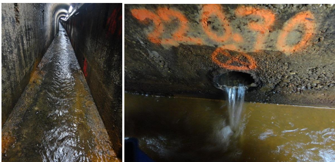
Figure 17 - Galerie aval (gauche) – Exutoire du joint de dilatation central (droite)
