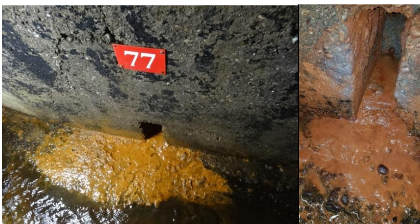
Figure 25 - Boues orange en sortie de barbacane n° 77 (gauche) et de la barbacane n°127
