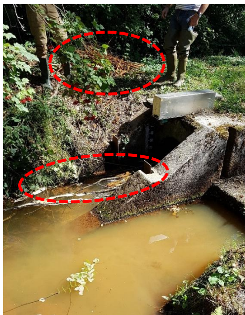
Figure 28 – Exutoire de la conduite 800mm au niveau de l'Avière
