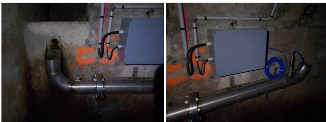
Figure 18 - Débitmètre NIVUS sur rameau Est de la galerie amont
