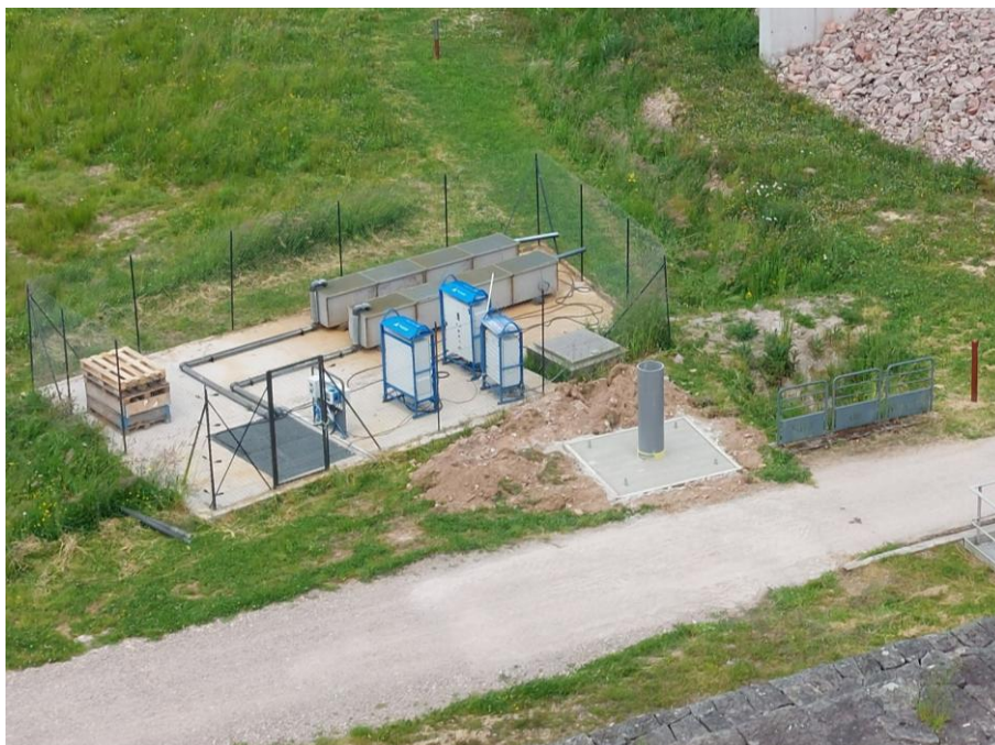
Figure 36 – Vu de la dalle sur le regard R0-R1 et des dispositifs de pompage et d'auscultation
