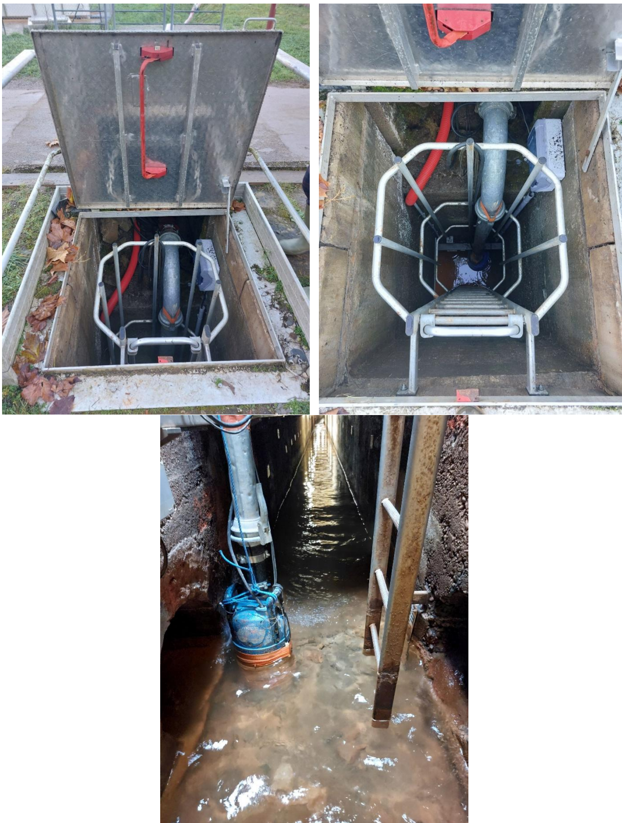
Figure 50 – Echelle d'accès au regard R0 (bas de l'échelle non fixé dans le GC)
