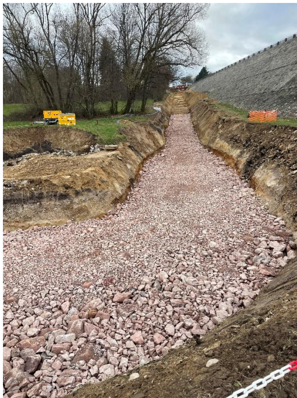
Figure 5 – Terrassements au cours des étapes de cloutage / mise en œuvre du ballast
