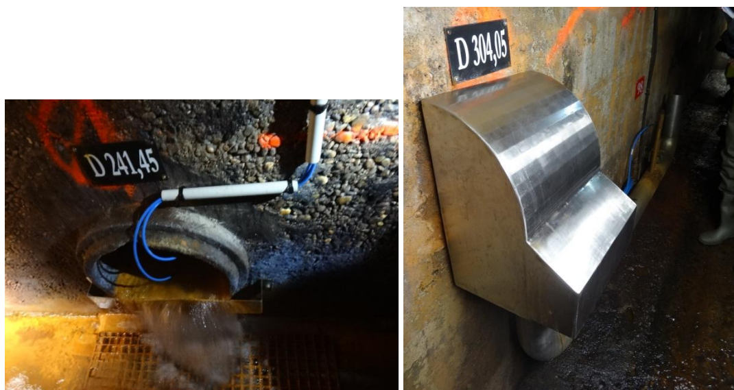
Figure 19 - Débitmètre à l'exutoire de la buse du puisard au PM 241,45 (gauche) , du joint de dilatation au PM 304,05 (droite)
